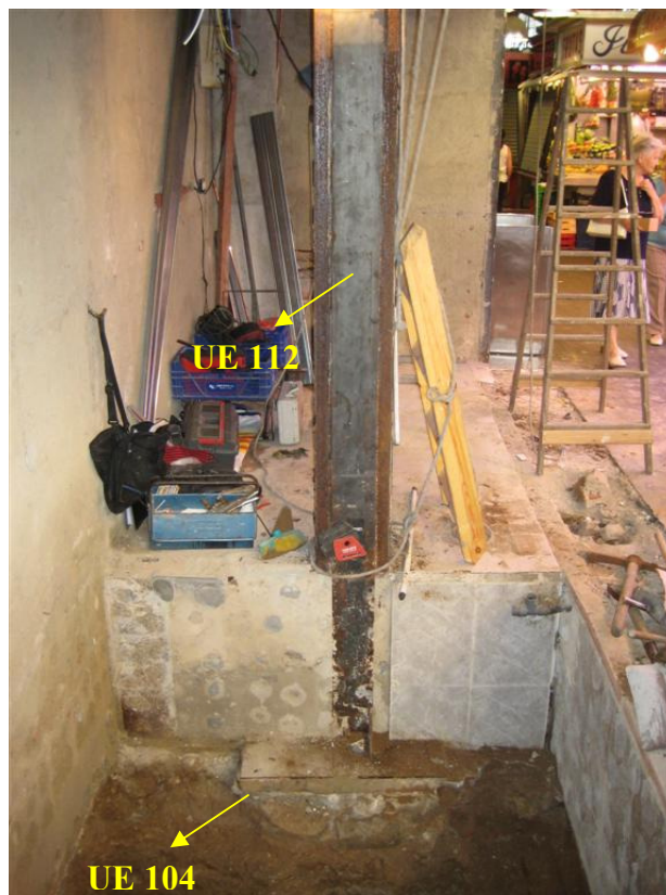
Estructures UE 104 i 112 (Foto 076-09 017)
