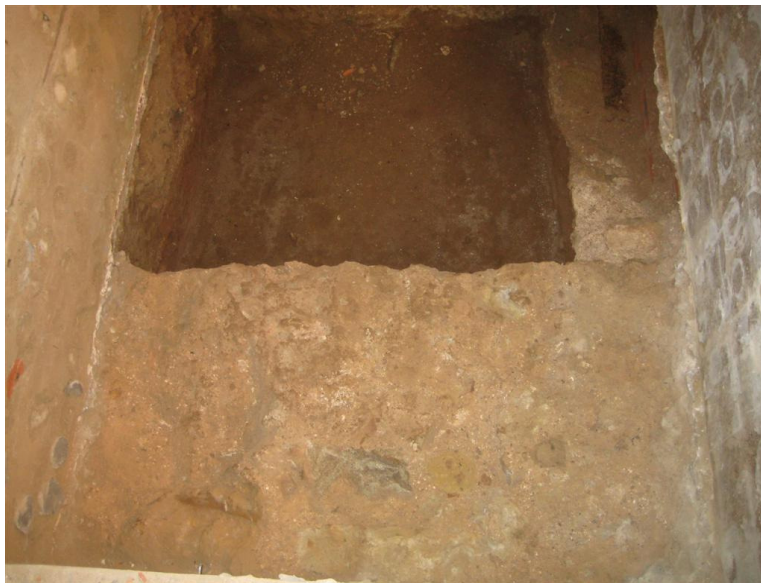
Estructura UE 105 (Foto 076-09 006)
