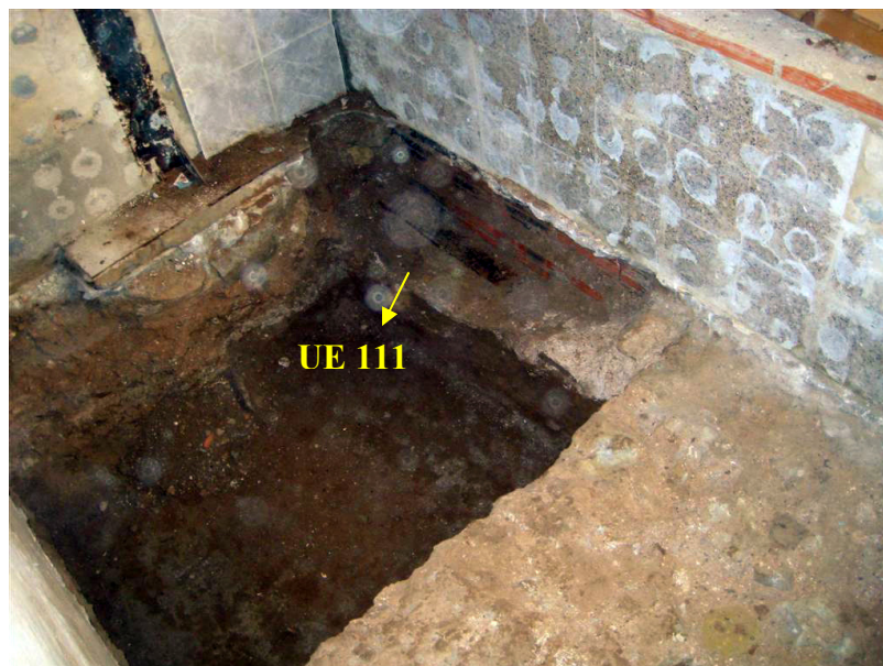
Estructura UE 111 (Foto 076-09 015)
